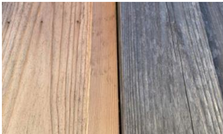
施工から8年経過中の木材
